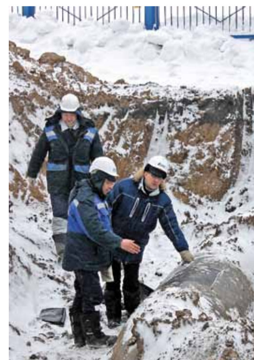
В этом году в Кемеровском ЛПУМГ в капитальный ремонт будут выведены 35 километров газопровода ПарABELь – Кузбасс
